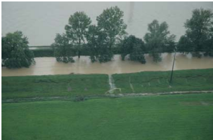
Abb. 5: Rechter Hintergraben, Hochwasserereignis August 2005: Ein Dambruch hätte mit grosser Wahrscheinlichkeit auch den Bruch des Hauptdammes zur Folge. Fig. 5: The right backside trench during the flood in August, 2005. A dam break would have most likely caused the break of the main levee as well.
