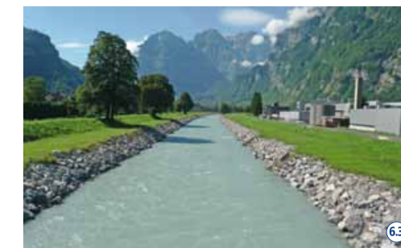
Sanierung Uferlängsverbau am Escherkanal. 6.3
