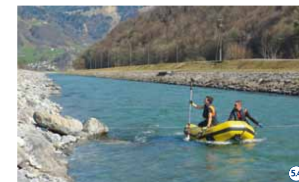
Systematische Vermessung des sanierten Escherkanals: Die Aufnahmen bilden die Grundlage für das nun anlaufende flussbauliche Monitoring. 5.4
