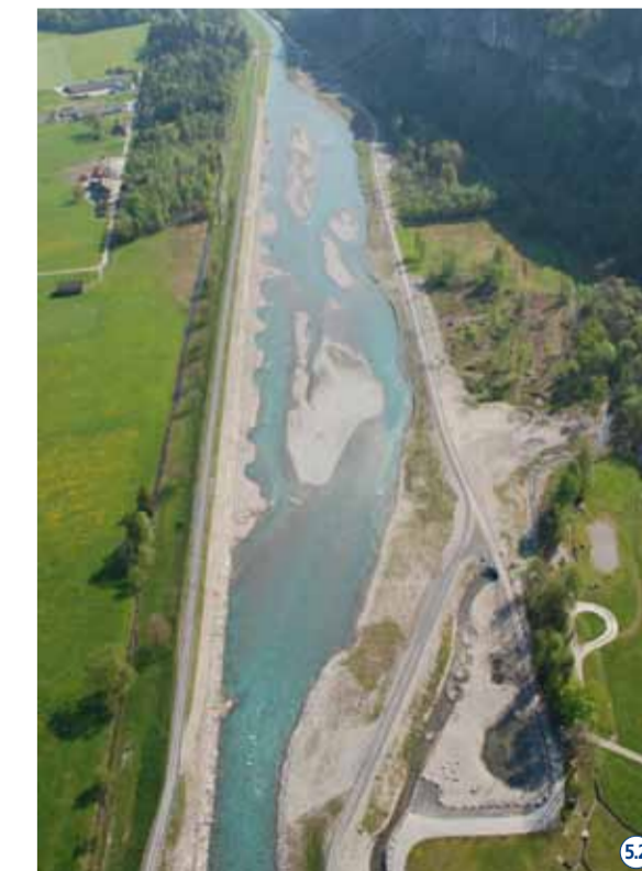
Im Chli Gätschachen ist die ursprüngliche Breite der Linth wieder hergestellt. 5.2
