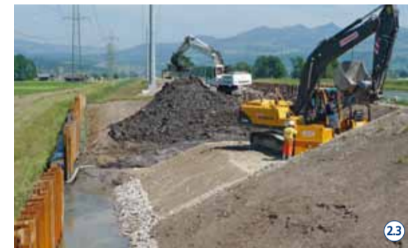
Im Gebiet Giessen wird der Damm aus Platzgründen mit der Variante Materialersatz saniert. 2.3
