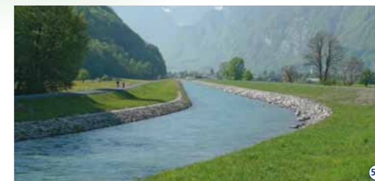
Chupferensteg: Aussendamm verstärkt, Innendamm und Längsverbau im bisherigen Zustand. 5.1
