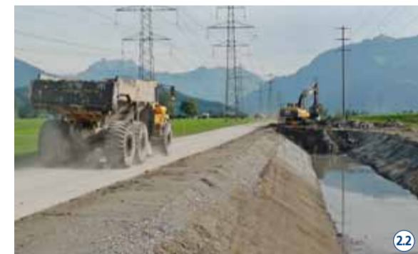
Die neue Nebengrabenstrasse dient als Baupiste. 2.2
