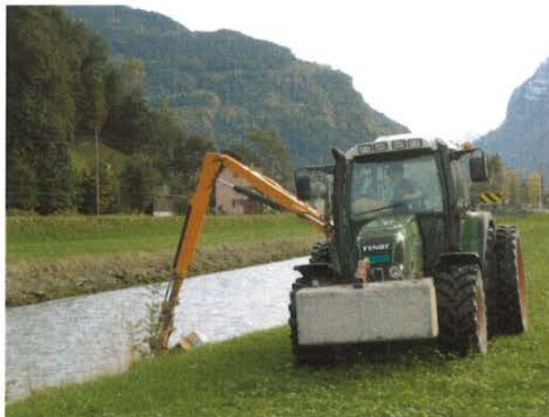
Bild 1: Mähen der Ufervegetation
