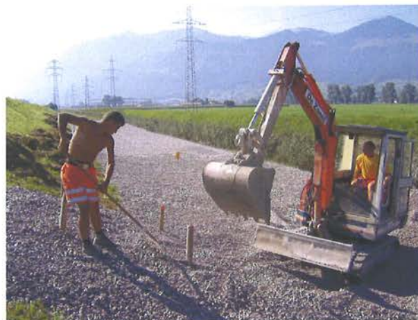
Bild 7: Sofortmassnahme bei Hauptdamms
