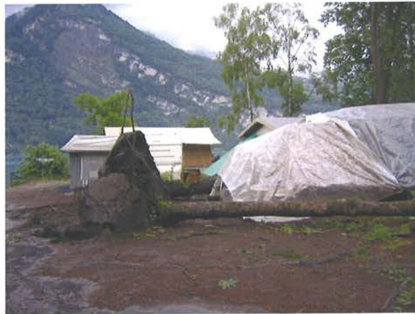
Bild 8: Sturmschäden beim Zeltplatz
