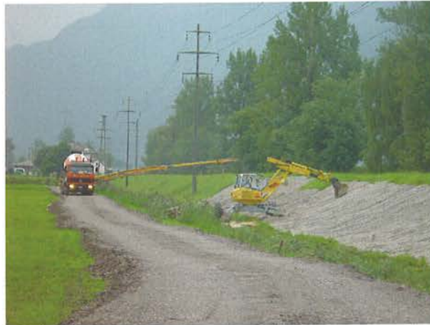
Bild 6: Akutmassnahme bei Hintergrabendamms
