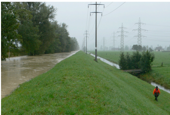
Bild 8: Dammüberwachung
