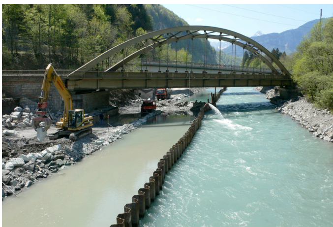
Bild 5: Arbeiten am linken Ufer
