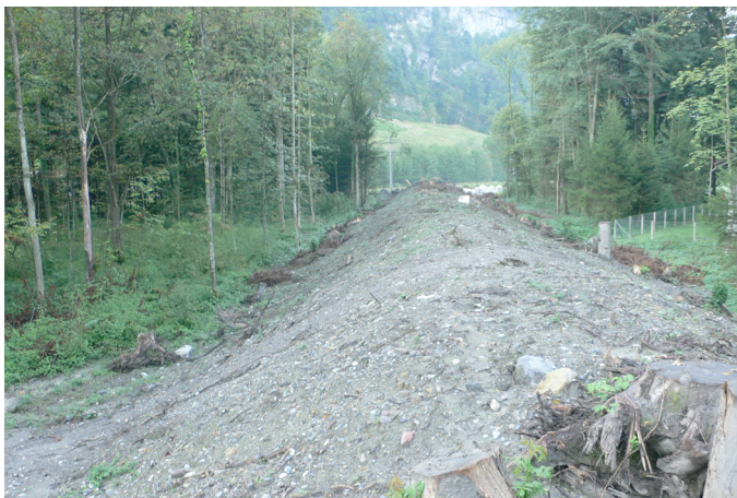
Bild 13: Fertig erstellter Damm
