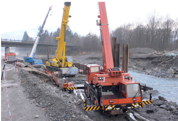
Bild 4: Einbringen Spundwände
