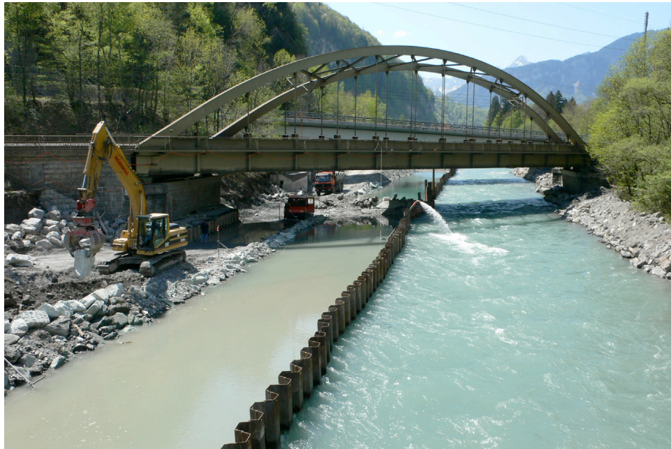
Instandstellungsarbeiten am Escherkanal-Unterlauf
