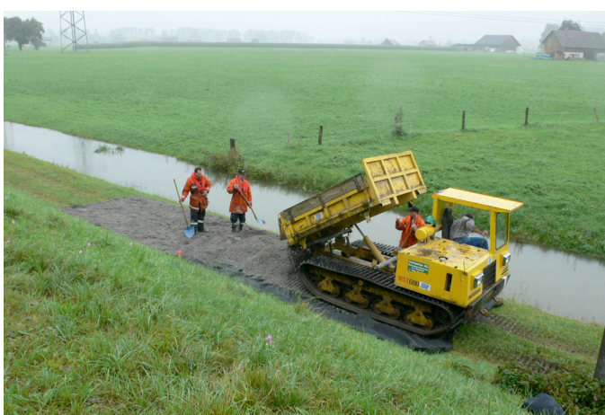
Bild 9: Aufbringen Auflastfilter
