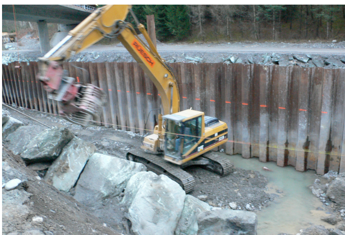
Bild 6: Arbeiten am rechten Ufer
