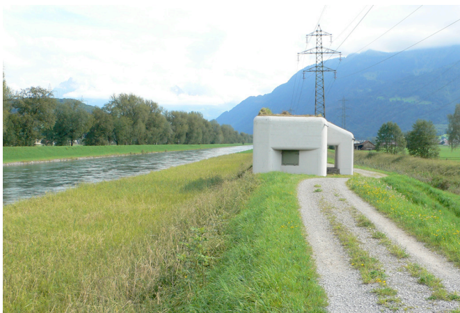
Bild 7. Bunker an der Linth
