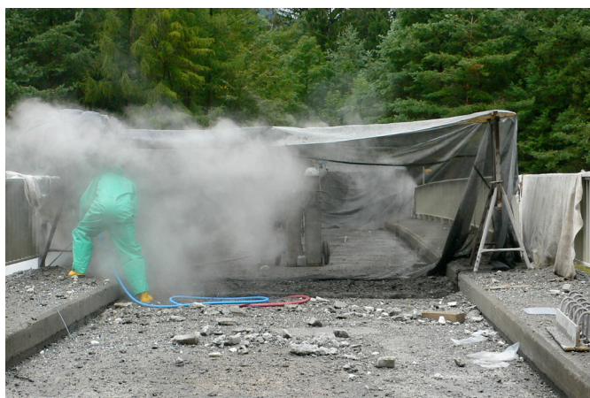
Bild 6: Entfernen Fahrbahnübergang
