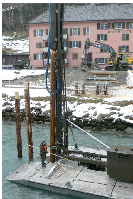
Bild 6: Rammen der Pfähle
