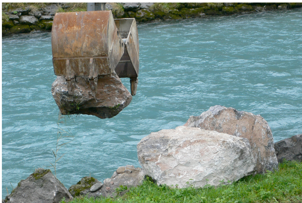
Der erste Stein im Projekt Hochwasserschutz Linth 2000 wird gesetzt (Escherkanal, 25. September 2008)
