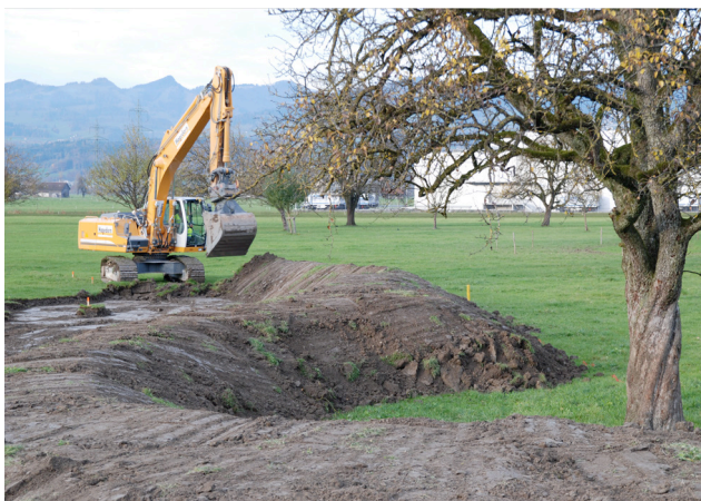
Bild 14: Baubeginn am Linthkanal
