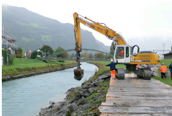
Bild 11: Längsverbau
