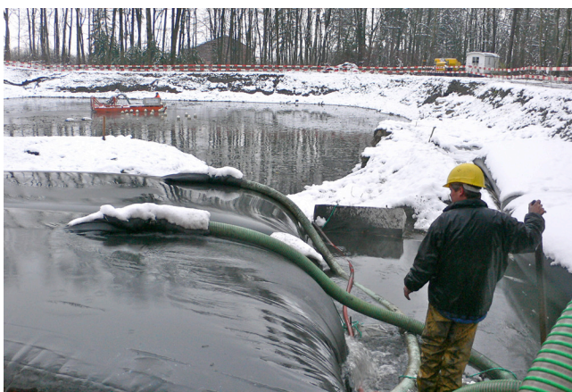
Bild 11: Absaugen der Sedimente
