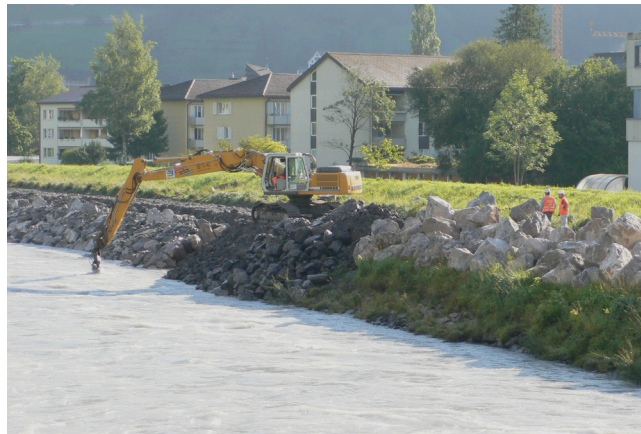
Bild 7: Sanierung Längsverbau
