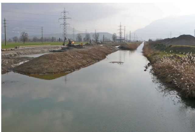
Bild 9: Verlegung der Gräben
