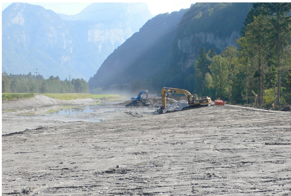
Bau des neuen Hochwasserschutzdammes bei der Flussaufweitung Chli Gäsitschachen, Escherkanal
