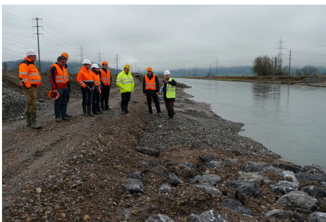
Bild 6: Die E-PL-OBL am Linthkanal
