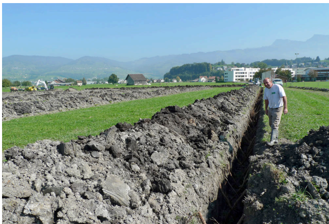
Bild 11: Zweitentwässerung
