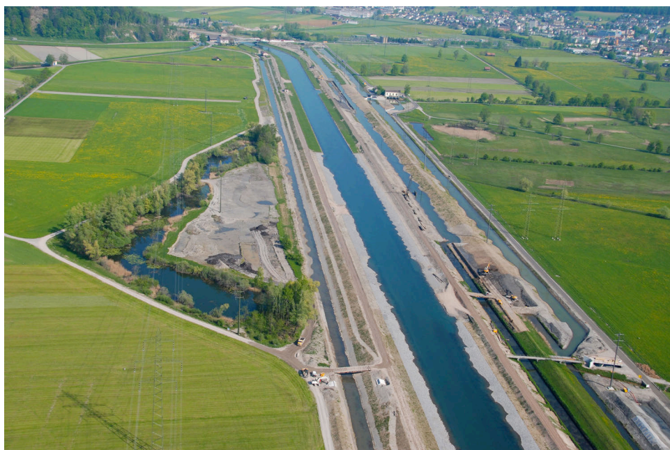
Bauarbeiten am unteren Linthkanal über die ganze Kanalbreite
