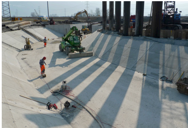
Bild 9: Zulaufbauwerk zum Pumpwerk
