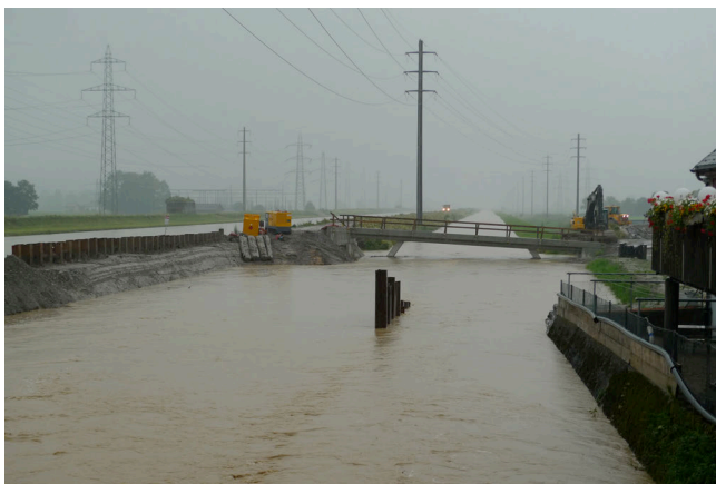
Bild 4: Hochwasser im Hintergraben
