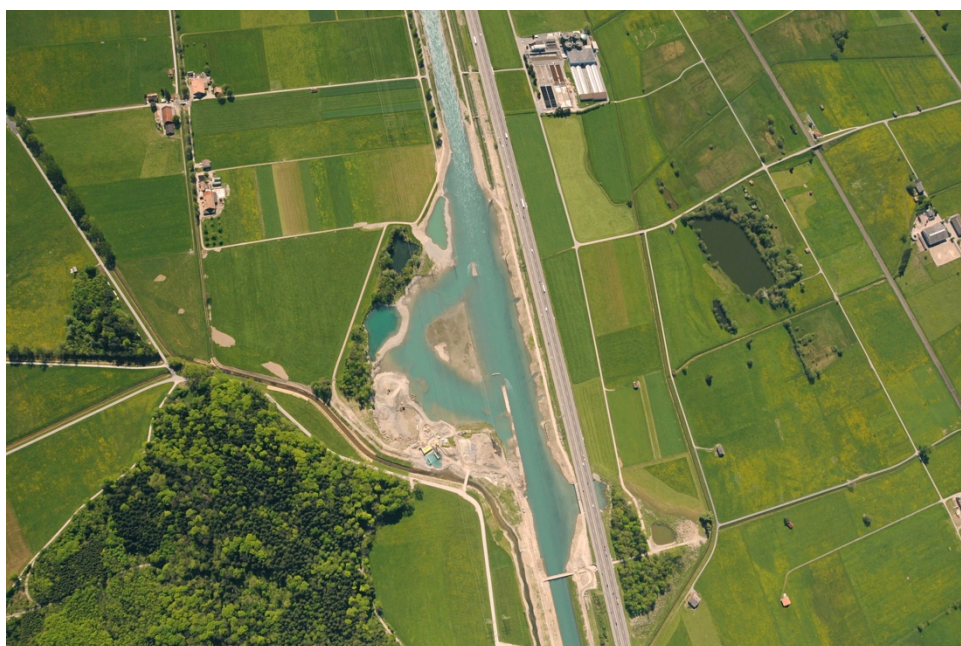
Luftbild der fast fertig erstellten Flusssaufweitung Hänggelgiessen am Linthkanal
