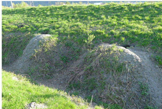
Abb. 4: Dachsbauten im Damm
