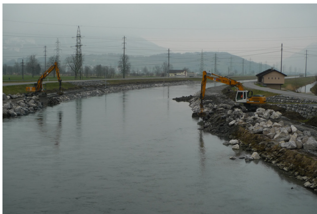
Abb. 7: Sanierung Uferlängsverbau
