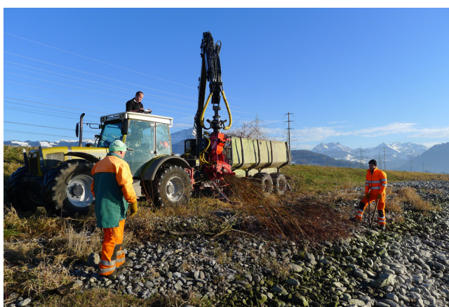
Abb. 3: Einsatz hydraulische Schere
