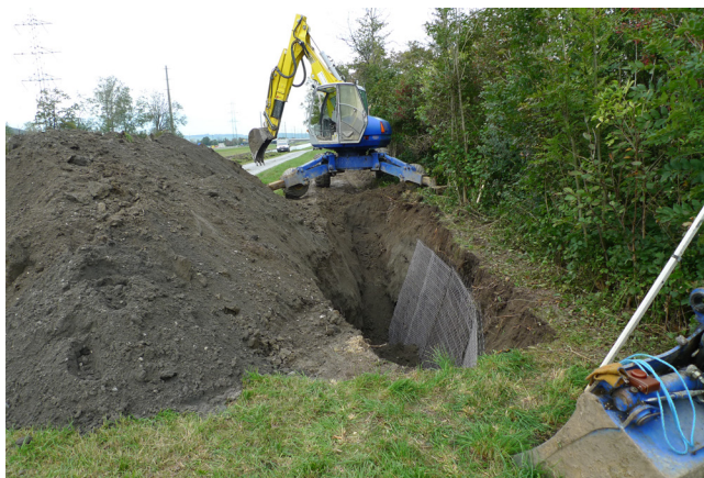
Abb. 6: Sicherung gegen Dachsbauten
