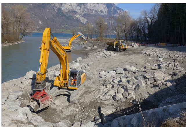
Abb. 3: Bau der neuen Kiesentnahme
