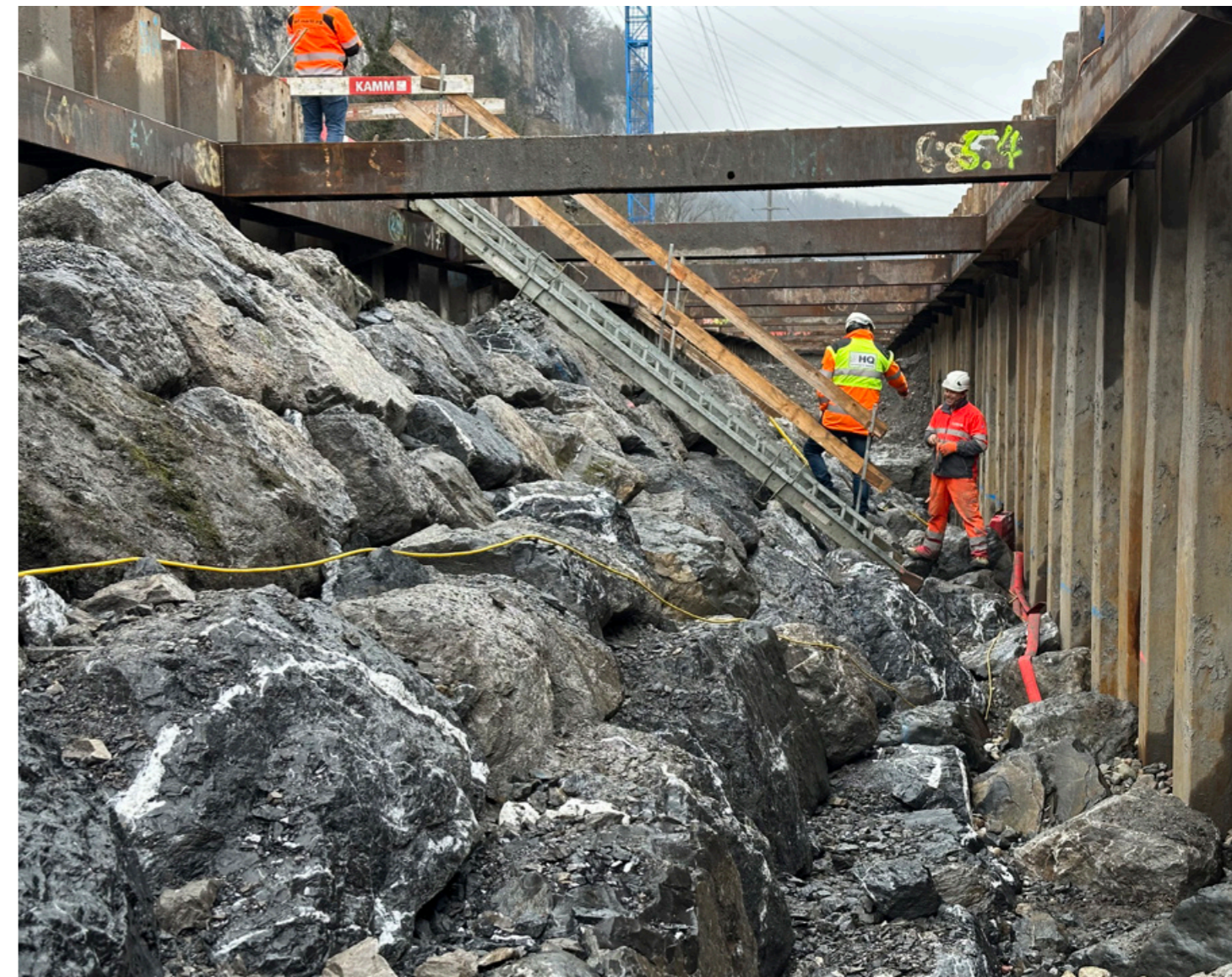
Wiederinstandstellung Wühr im Bereich der Rutschung
