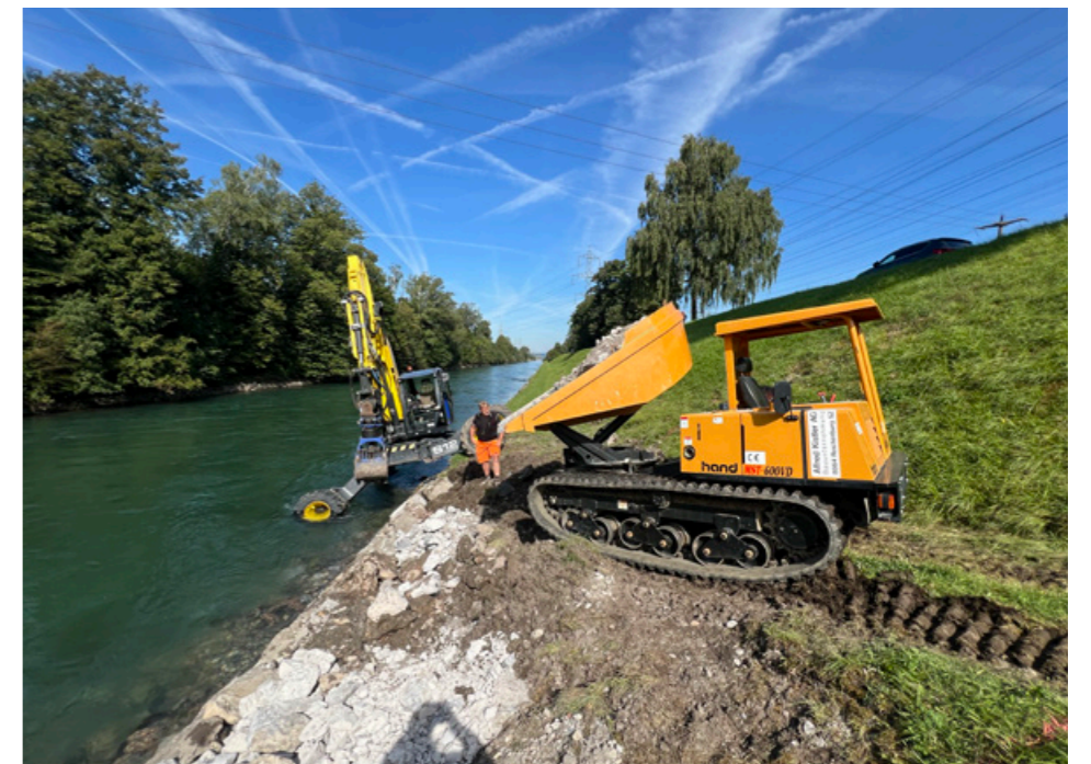
Instandstellung des Wuhrs am Linthkanal bei Ziegelbrücke
