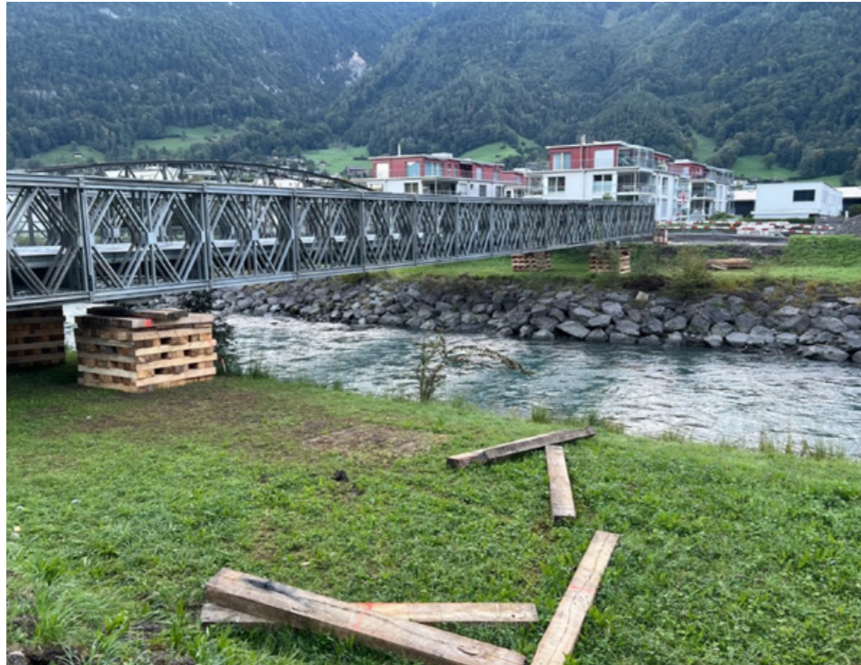
Einbau der Hilfsbrücke für das Eidgenössische Schwing- und Älplerfest (ESAF)
