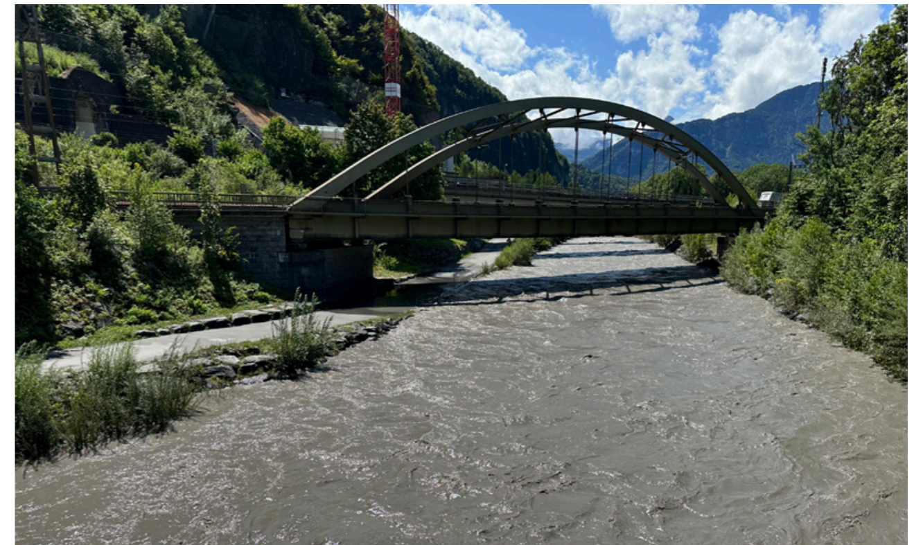
Abklingendes Hochwasser am Escherkanal
