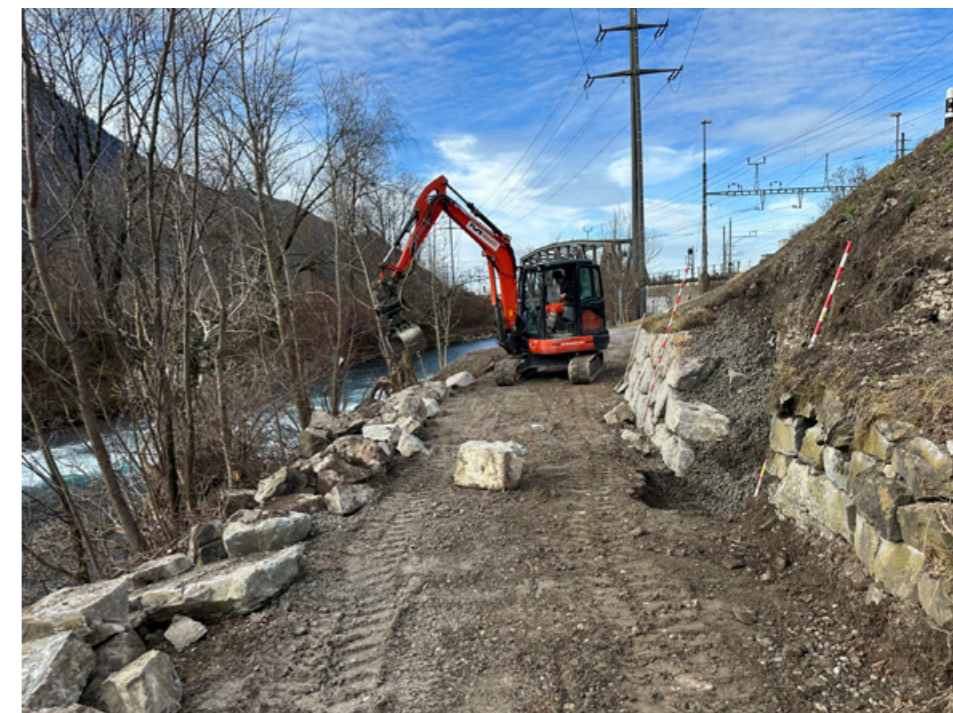
Ersatz Stützmauer in Ziegelbrücke
