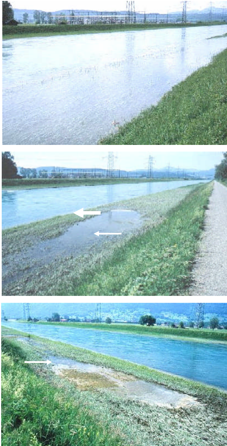
Abb. 4.3.19: Beispiel für den Verlust von Äschenlarven-Lebensraum durch sinkenden Wasserpegel. Situation vom 23.-25. Mai 2000 bei LC 39 rechtsufrig. Oben (23. Mai; Q_{\text{mittl.}} = 110 \text{ m}^3\text{s}^{-1} ): Es fanden sich Larven vom Dammfuss bis zu 6 m gegen die Flussmitte hin. Mitte (24. Mai; Q_{\text{mittl.}} = 105 \text{ m}^3\text{s}^{-1} ): Im noch mit dem Hauptgerinne verbundenen Tümpel fanden sich etwa 100 Larven (dünner Pfeil). Mehrere 100 Larven hielten sich an der Graskante direkt auf der betonierten aber überströmten Mauerkrone auf (dicker Pfeil). Unten (25. Mai; Q_{\text{mittl.}} = 102 \text{ m}^3\text{s}^{-1} ): Im isolierten Tümpel (Pfeil) blieben rund 70 Larven zurück. Er trocknete in den Folgetagen aus. Das Wasser sank weiter bis ins betonierte Kanalbett ab, so dass sich infolge der hohen Stömungsgeschwindigkeiten ( > 40 \text{ cm s}^{-1} ) direkt am betonierten Ufer keine Larven mehr auf dieser Strecke halten konnten.
