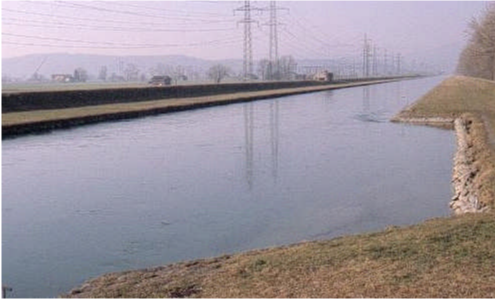
Abb. 3.3: Typischer Linthkanal-Abschnitt bei mittlerem Wasserstand bei Giessen (Fließkilometer 11) mit Blick flussabwärts. Im Vordergrund eine sogenannte Haabe, eine der 22 künstlichen Einbuchtungen.
