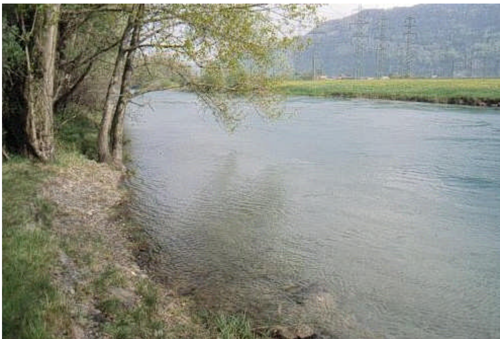
Abb. 3.4: Der einzige kurze Uferabschnitt des Linthkanals mit naturnahem Charakter unterhalb der „Biäsche“ bei Fließkilometer 1.4.
